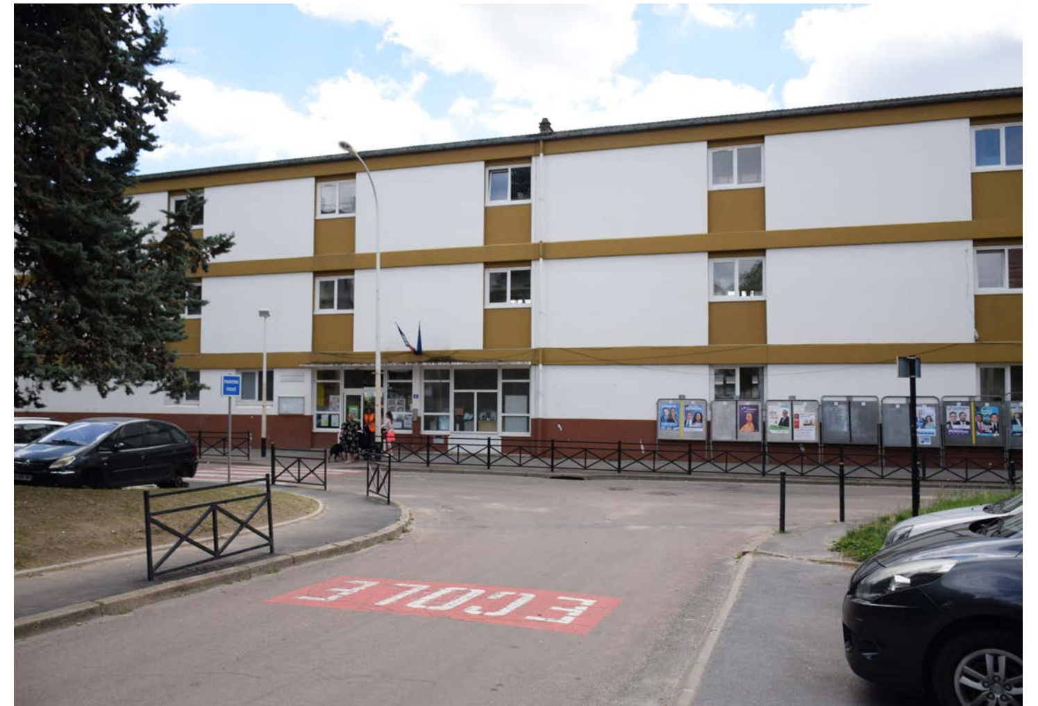
L'école des Cahouettes va bénéficier de travaux de rénovations énergétiques.
