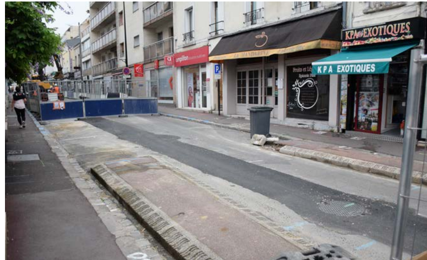
Les travaux de création du réseau d'assainissement avancent selon le calendrier établi. À ce jour, plus d'une cinquantaine de mètres de pose de réseaux a été réalisée avenue du Maréchal Foch.
