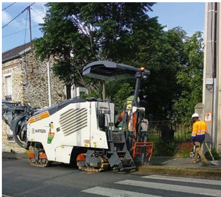
Rabotage de la chaussée, avenue Georges Clemenceau - juillet 2021.
