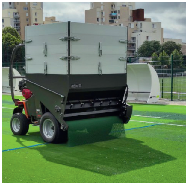
Pose d'un gazon synthétique sur le terrain
