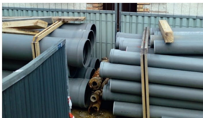
Travaux d'assainissement rue Victor Hugo
