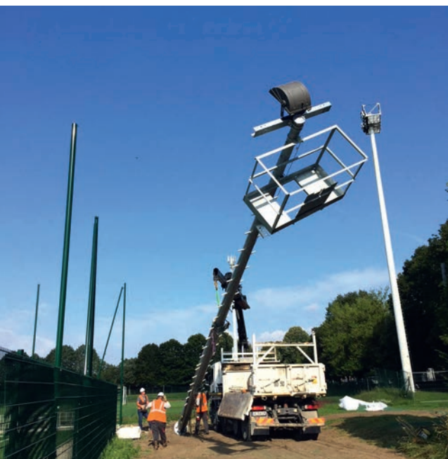
Positionnement des mâts d'éclairage par une grue
