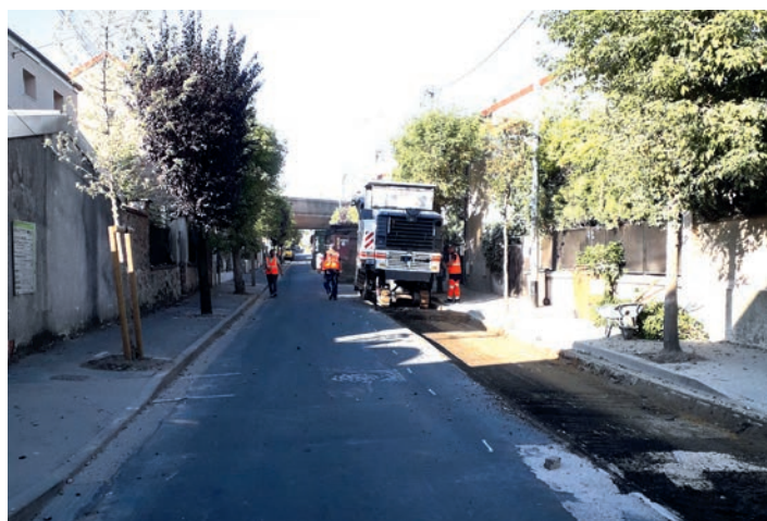
L'enrobé refait à neuf rue Pasteur à l'issue des travaux
