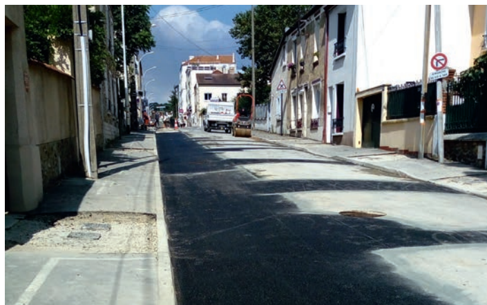
Opérations de raccordement des particuliers à l'assainissement avenue Georges Clemenceau
