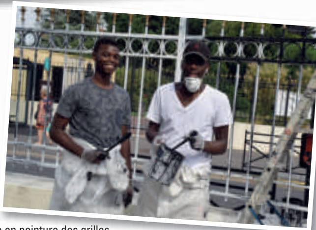
Mise en peinture des grilles Voie Lamarque pour CAMARA Maro et CHARLES Thierry
