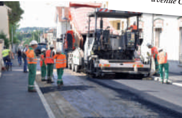
Réfection des trottoirs, avenue Carnot
