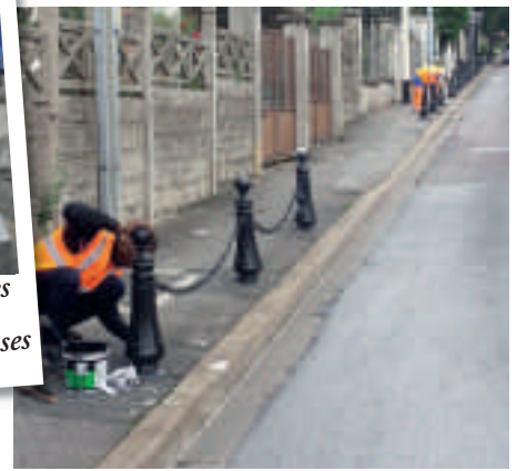
Rénovation du mobilier urbain, côte des Fauvettes
