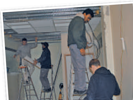
Création d'une installation électrique et d'un faux-plafond à la bibliothèque municipale
