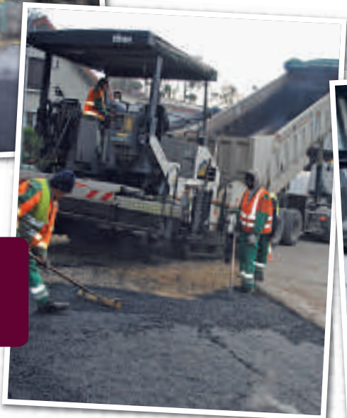
Réfection de la chaussée : rue des Loges d'Avron
